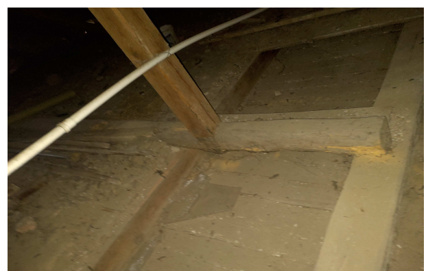
Widoczna skorodowana belka podwalinowa
