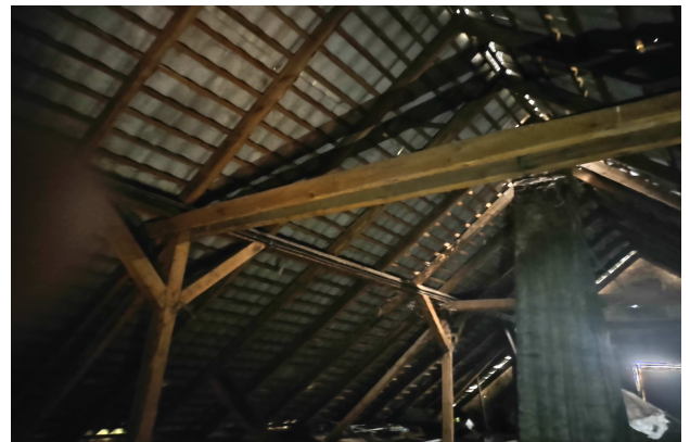
Widoczny dobry stan więźby
