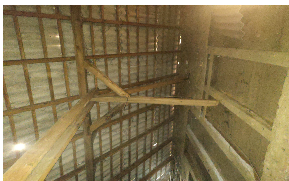
Widoczny brak belki podwalinowej i przesunięty słup
